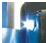
Iluminación interior mediante LEDs de bajo consumo
